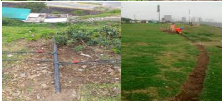
Trabajos de mantenimiento del sistema de riego del Acantilado de la Costa Verde – Cambio de mangueras de 16 mm.
