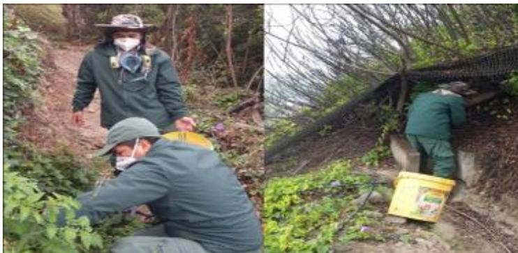
Cambio de manguera principal de caudal y ramales principales de sistema de riego tecnificado del Acantilado de la Costa Verde.
