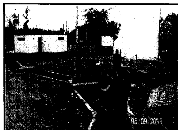
Operación de la Planta de Tratamiento.
