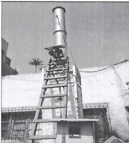
Sistema de depuración (Chimenea ecológica)
