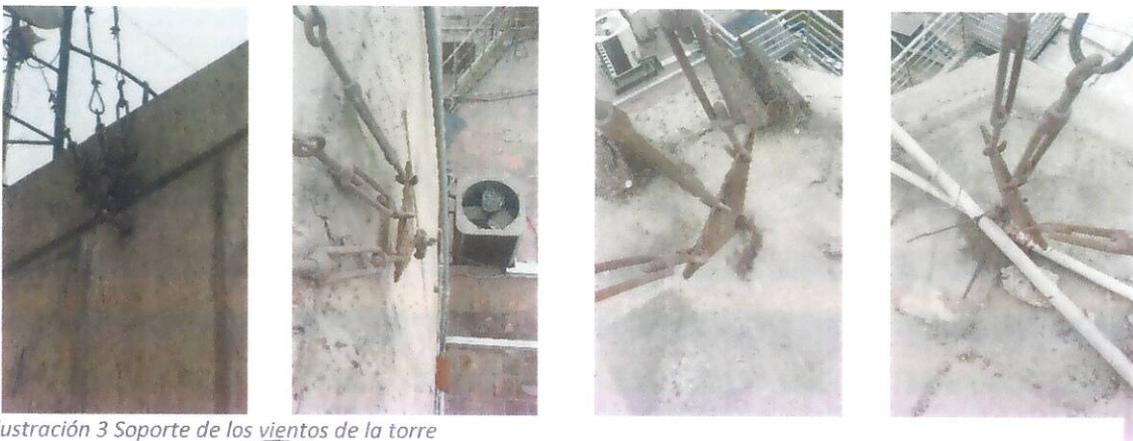
Ilustración 3 Soporte de los vientos de la torre
